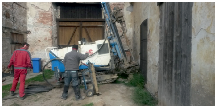
Realizace mikropilot DN 130 délky 6 m
